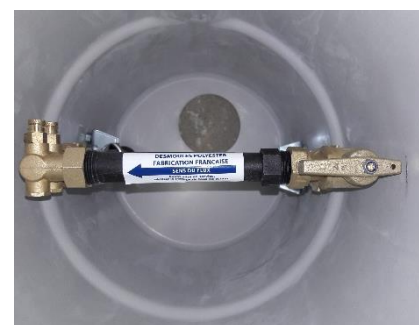
Montage pour compteur DN15 lg 170 mm
