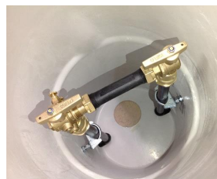
Montage pour compteur DN15 lg 110 mm
